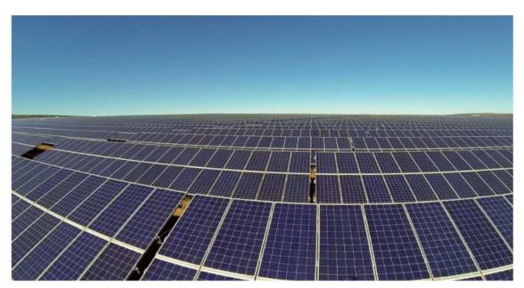
مشروع جاسبر للطاقة الشمسية الكهروضوئية Jasper Solar PV Power Project، في جنوب إفريقيا. يتكون مشروع جاسبر من 325000 لوح شمسي بسعة 96 ميغاواط. دخل المصنع الخدمة في أكتوبر 2014 وهو حالياً الأكبر في إفريقيا. اعتباراً من عام 2016، تبلغ قدرة أكبر محطة للطاقة الشمسية في جميع أنحاء العالم 648 ميغاواط وتقع في كاموثى، تاميل نادو، الهند.
