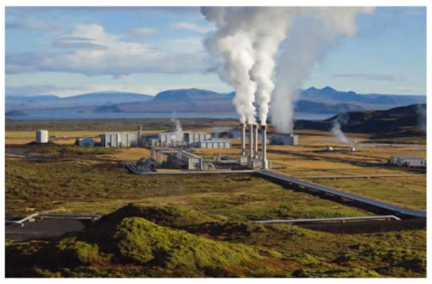
محطة نيسجافلير Nesjavellir لتوليد الطاقة في أيسلندا؛ تعطي 120 ميغاواط من الطاقة الكهربائية بالإضافة الى 380 ميغاواط من الطاقة الحرارية من 83 درجة مئوية من المياه في عام 2010، وتصل درجات حرارة الخزان إلى 380 ميغاواط من الطاقة الحرارية عن 380 درجة مئوية.
