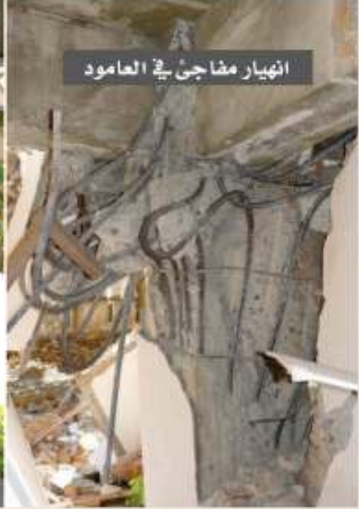
عدم قدرة الجسر على مقاومة الإجهادات اللزالية عند منسوب الأساسات مما أدى إلى حدوث انهيار قصي عند نقطة إتصال أعمدة الطابقين
