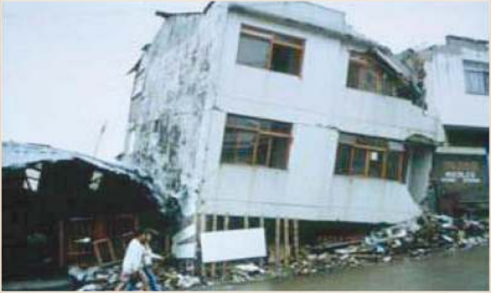
انهيار ناتج عن اختلاف مناسيب التأسيس
